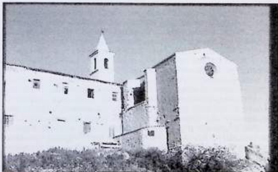
Fig. 2 – retroprospetto con l'annesso convento
