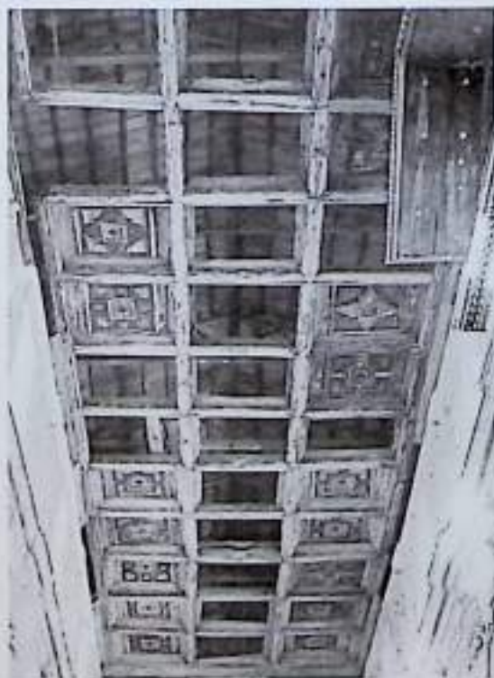
Il tetto a cassettoni al termine delle riprese
